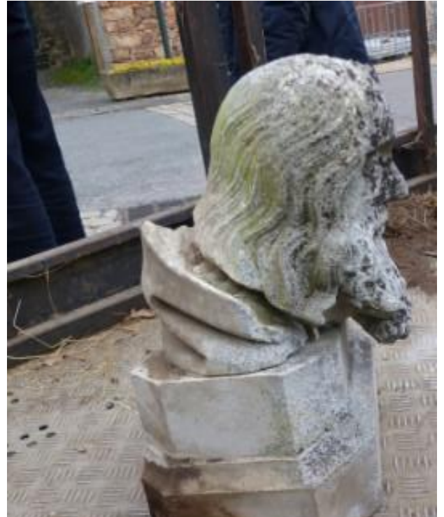
Profil droit montrant le décollement de la tête et son basculement vers l'avant
