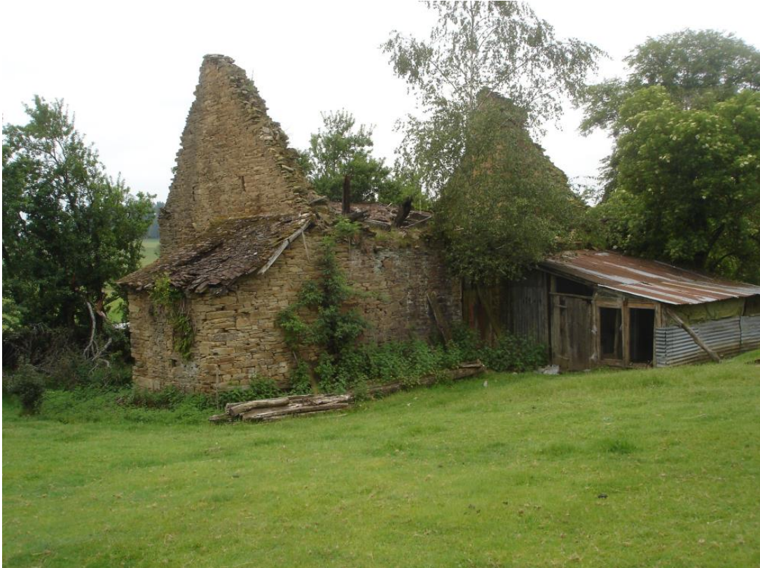
Maison d'habitation mentionnée dans l'Etat des fonds de 1749 Le séchoir effondré récemment était contre le pignon arrière. Contre le pignon avant se trouve une étable à cochons
